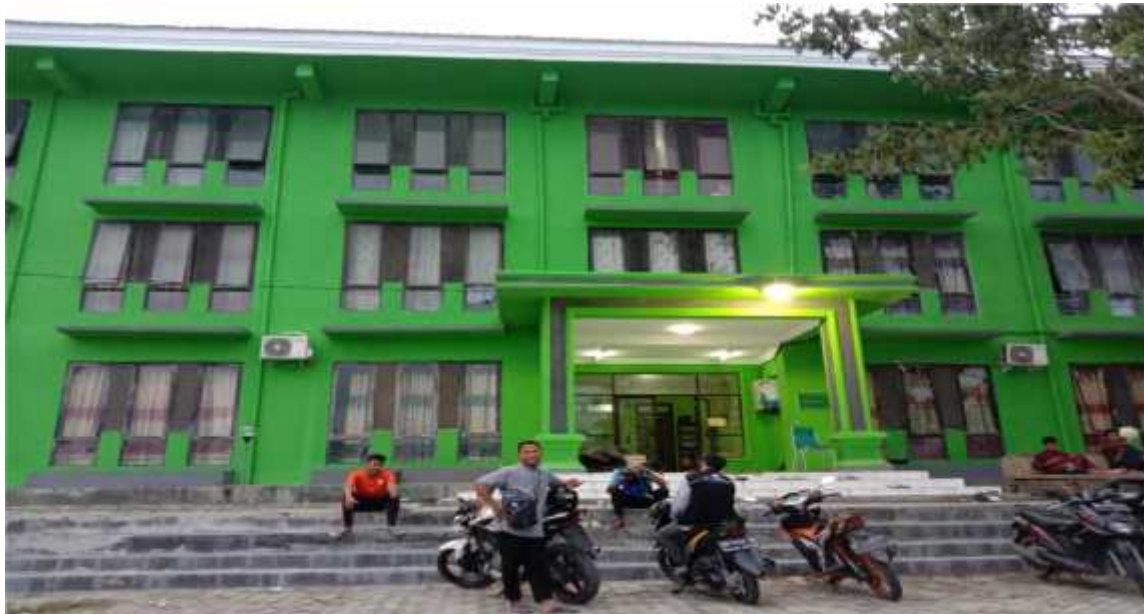
13. Gambar gedung putra Ma'had Al-Jami'ah IAIN Palu
