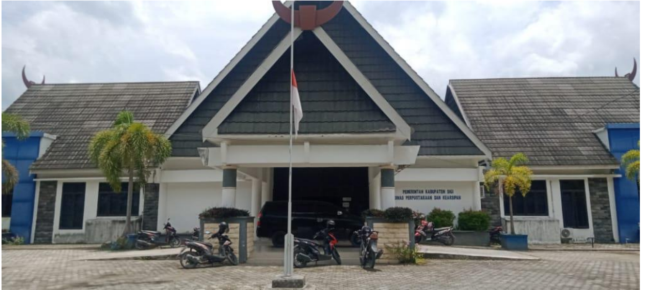
Gedung Di Dinas Perpustakaan Dan Kearsipan Kabupaten Sigi ( Sesudah Gempa )
