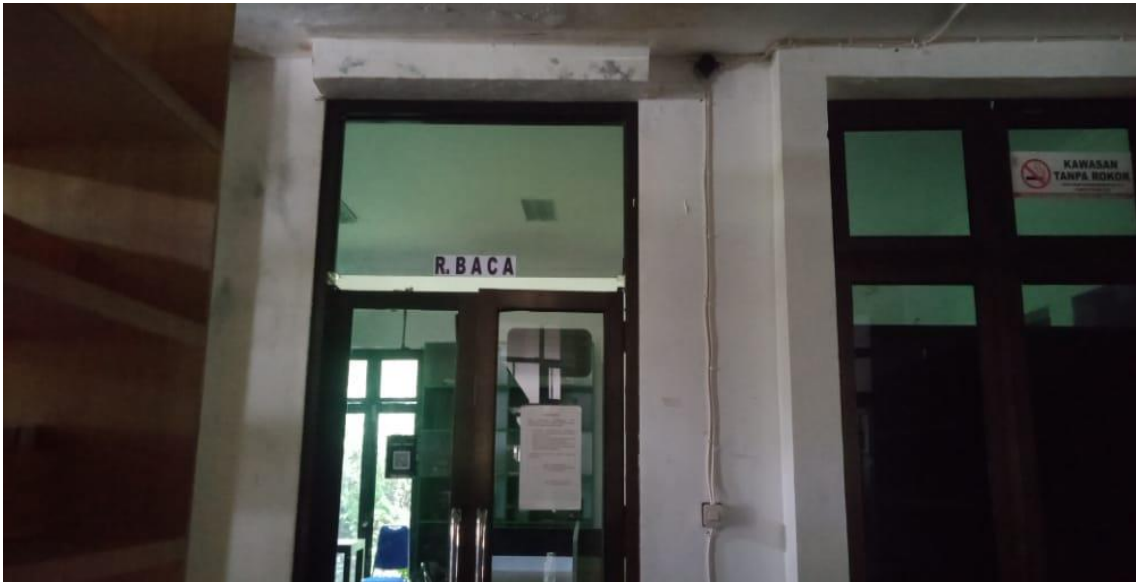
Ruang Baca ( Sebelum Gempa )
