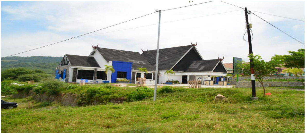
Gedung Di Dinas Perpustakaan Dan Kearsipan Kabupaten Sigi ( Sesudah Gempa )
