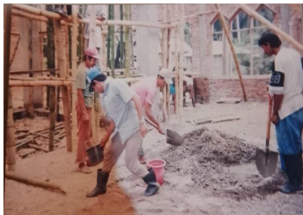
Gambar 4.11 Pembangunan Mesjid kedua di Kampung Rojo pada tahun 1989.
