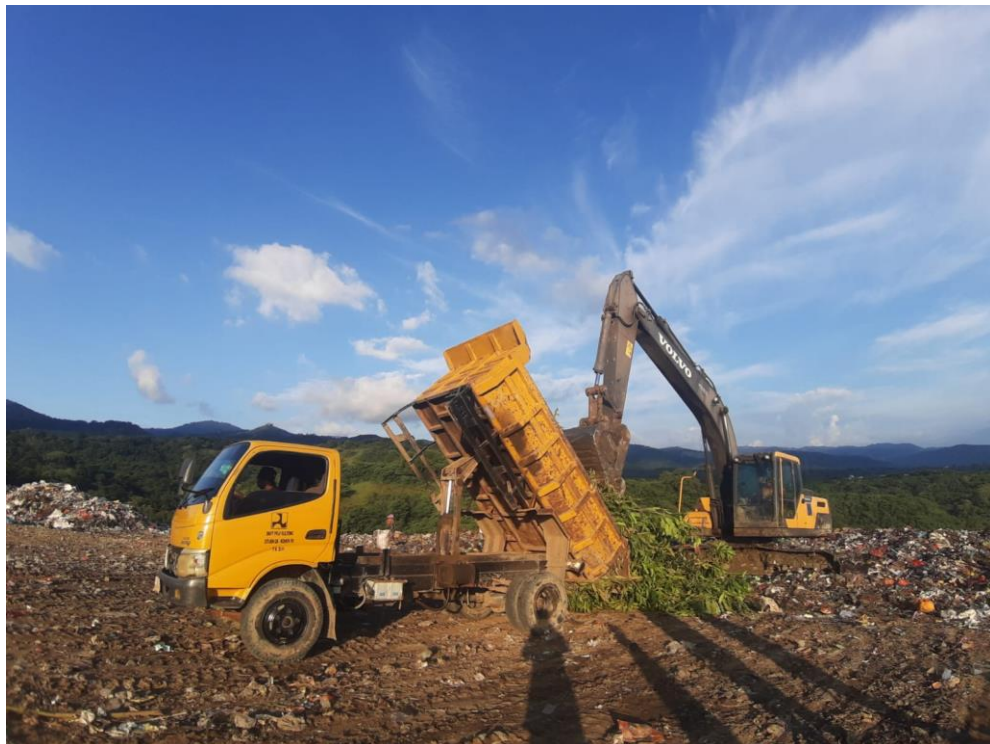
Gambar 10 : foto proses pembuangan sampah dari truk ke lokasi pembuangan akhir, Hari Kamis, 27 Juni 2024
