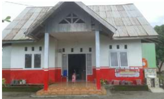
Gambar 9 kantor Desa Budong-budong
