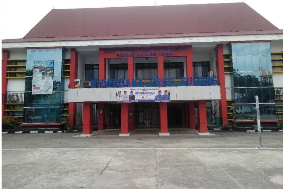
Gedung Dinas Perpustakaan dan Kearsipan Provinsi Sulawesi Tengah
