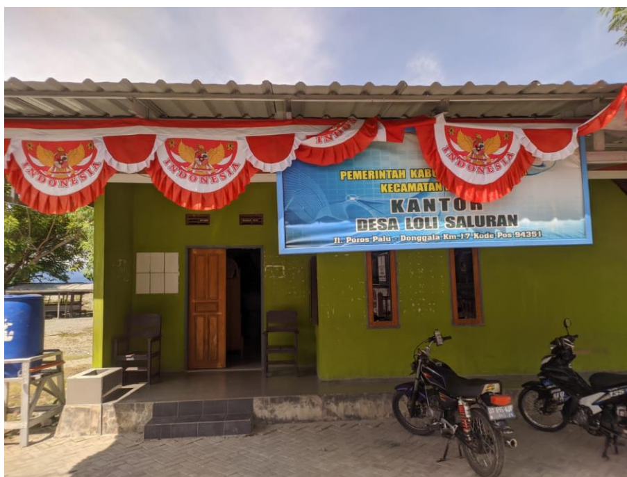
Kondisi Kantor Desa Loli Saluran Dari Jalan Poros Palu Donggala
