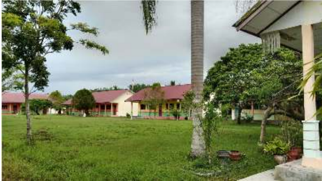
Gambar 1: Dokumentasi gedung SMKN 2 Baras
