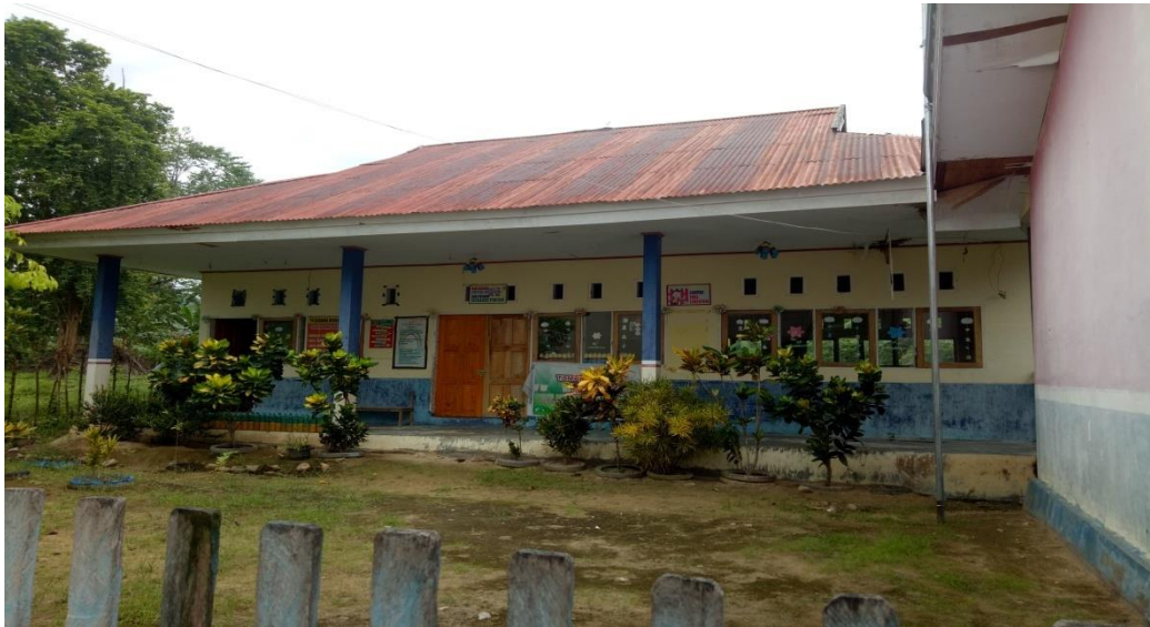
Foto Dokumentasi Gedung TK Satap Kadamba Nungana
