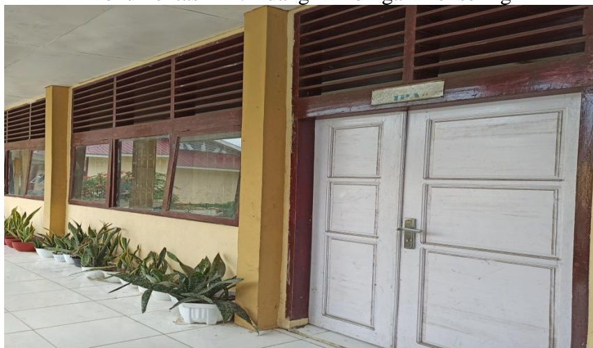
Dokumentasi 15 : Ruang Laboratorium IPA
