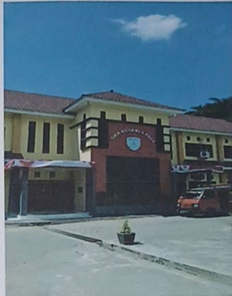
Gambar 2 : tampak depan Gedung SMAN 4 Palu
