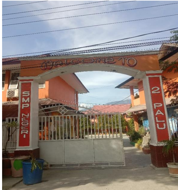
Gambar 5. Tampak Gedung Depan Sekolah
