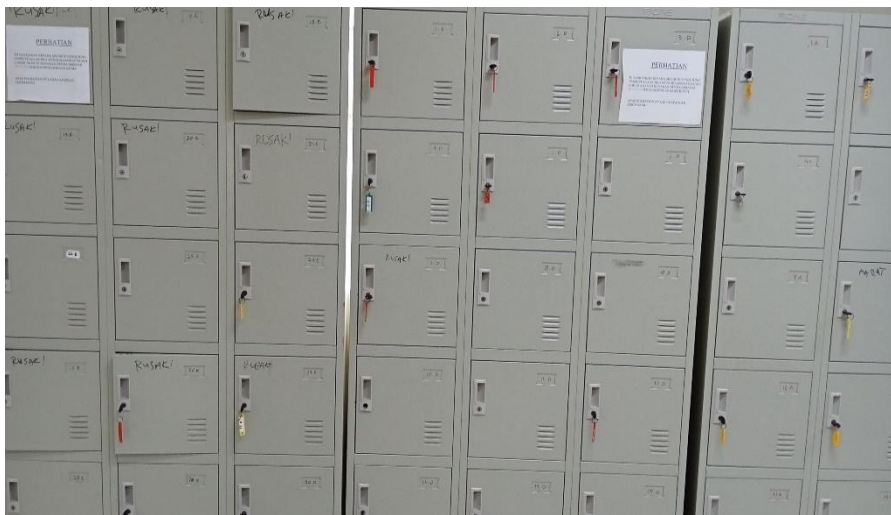
Beberapa loket penyimpanan barang yang rusak
