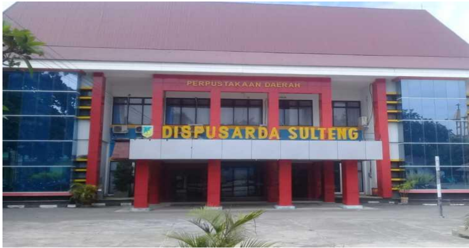
GEDUNG DINAS PERPUSTAKAAN DAN KEARSIPAN PROVINSI SULAWESI TENGAH
