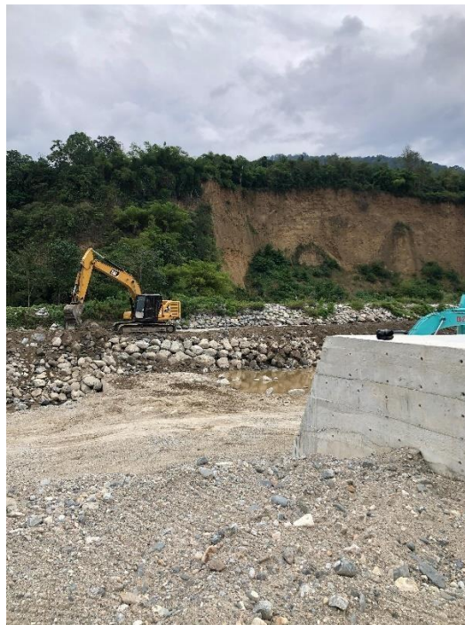
Proses Pembangunan Sabodam Gumbasa
