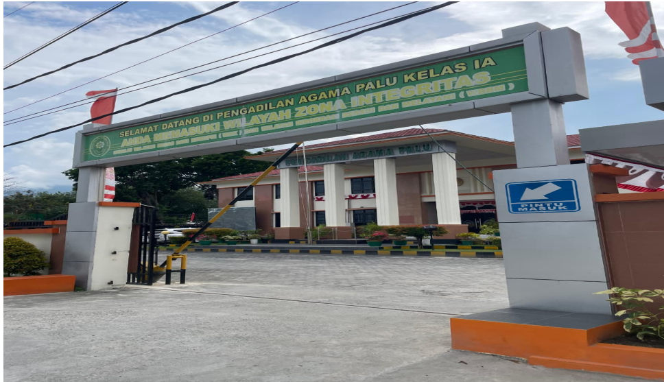
Gambar 1.1 Gedung Pengadilan Agama Palu kelas 1A
