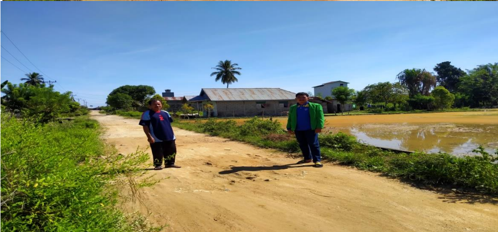
(Kondisi jalan yang menghubungkan 3 dusun)
