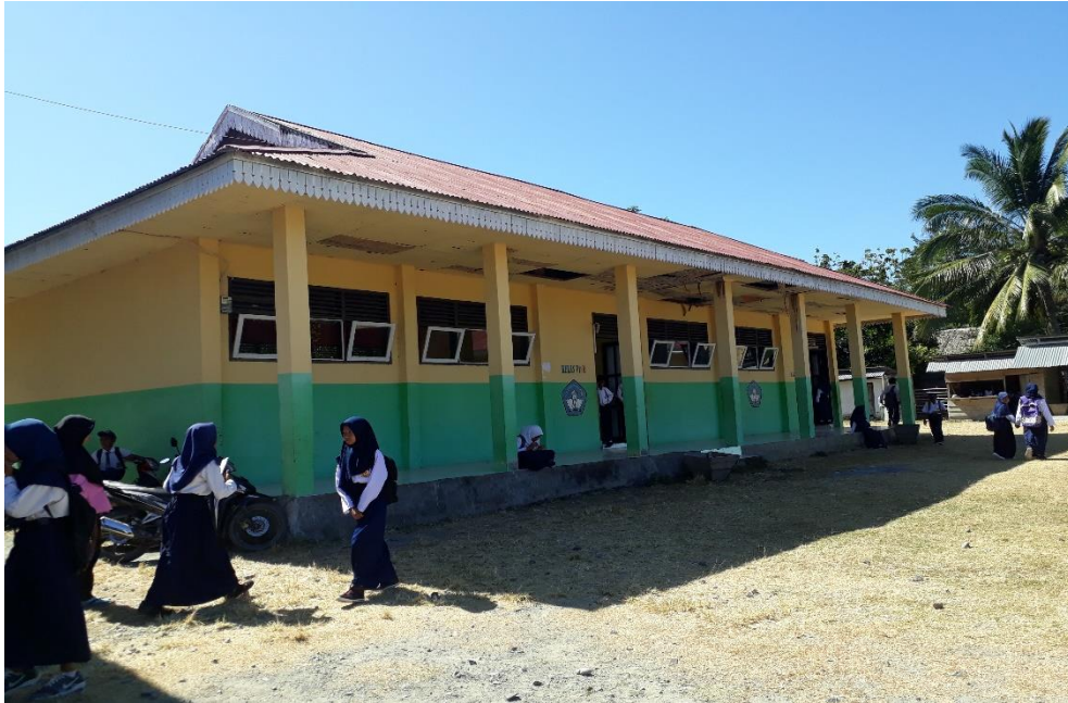
Gambar 7: Gedung SMP Negeri 4 Bualemo Tampak Dari Depan
