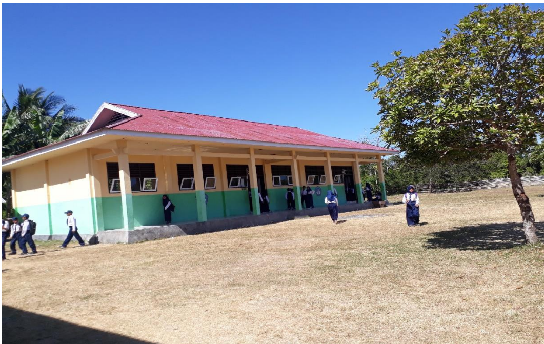
Gambar 6: Gedung SMP Negeri 4 Bualemo Tampak Dari Depan
