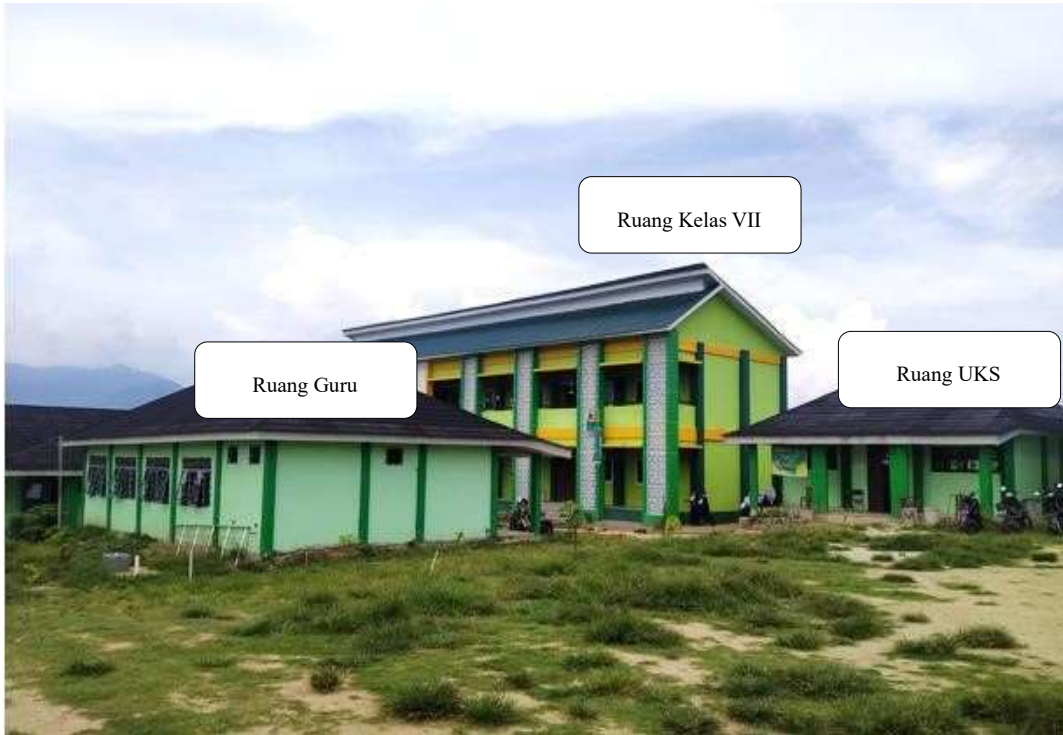
Gambar. 4 Ruang Guru, Ruang Kelas VII, dan Ruang UKS
