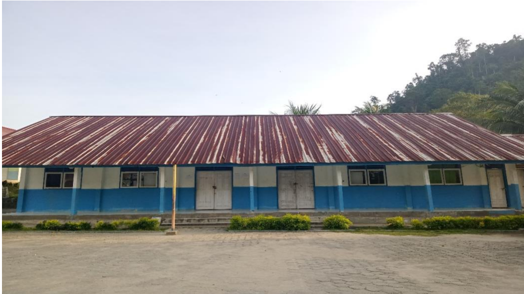
Dokumentasi Bangunan Sekolah SDN Salmekar dusun III (Bangunan ini didirikan pada tahun 2004 dan diresmikan pada tahun 2006 ) Dokumentasi bangunan sekolah SMP dusun IV Despot (Sekolah ini didirikan satu lingkungan dengan sekolah SD dan juga TK/PAUD) Dokumentasi Bangunan Sekolah dasar dusun IV Despot
