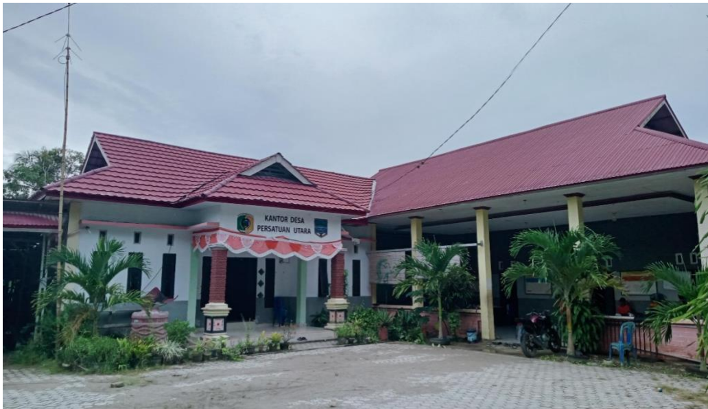
Dokumentasi bangunan Kantor Desa Persatuan Utara(Bangunan ini didirikan dari tahun 2010 dan diresmikan tahun 2011 seiring dengan pemekaran desa)
